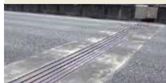
伸縮装置(橋の継ぎ目)
