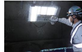
トンネル照明の点検
